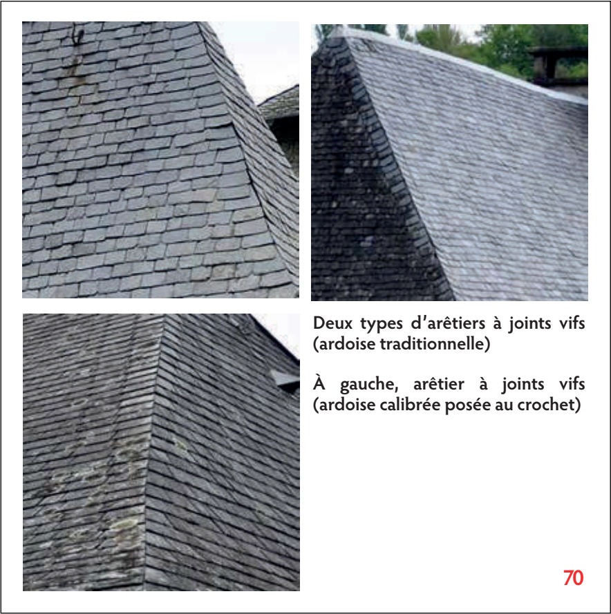
Mode de pose de l'ardoise traditionnelle.
