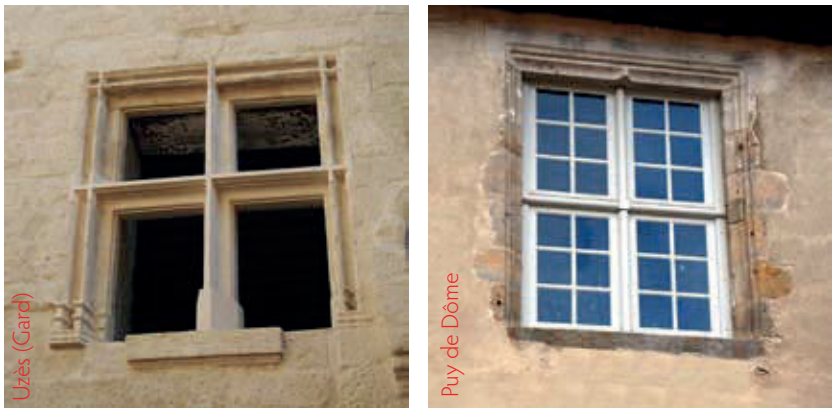
Deux manières de restituer une croisée : à l'identique, en pierre, ou en bois, en l'interprétant.
