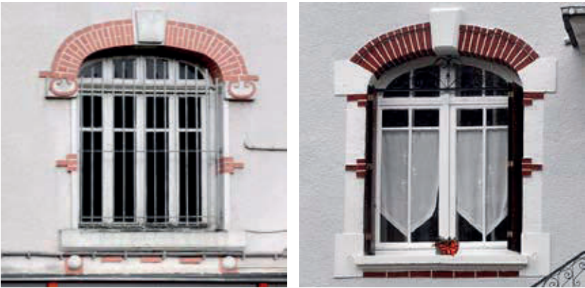
Fenêtres cintrées de la période 1900-1920 : elles sont impérativement re-divisées selon des schémas constants, par des menuiseries de bois alternant épaisseur et minceur. 114
