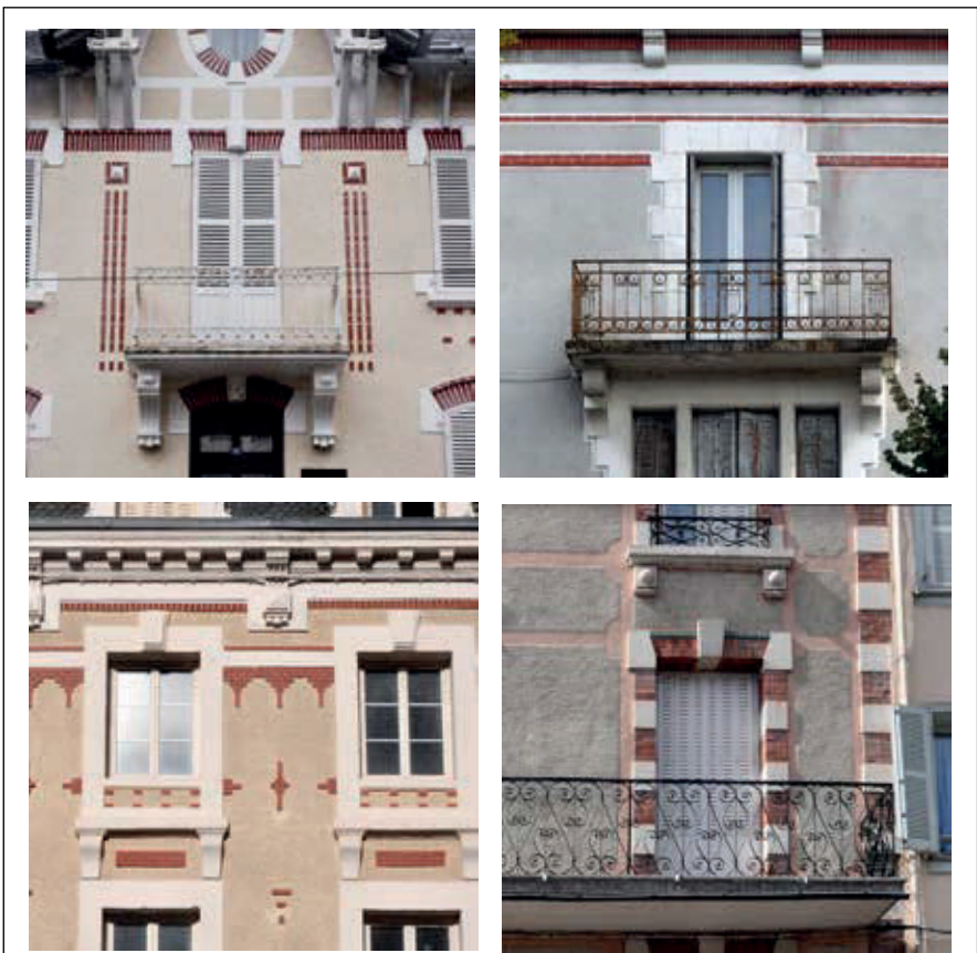
Groupe n°2 : façade comportant des parties en matériaux invariants (pierre, brique) et une partie enduite (évolutive) 44
