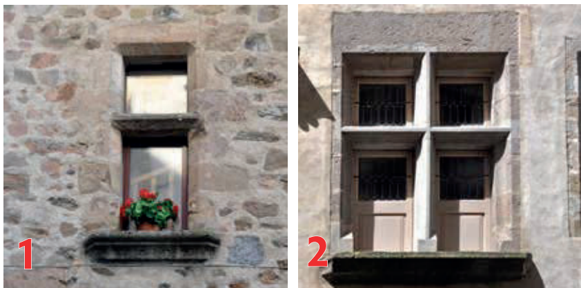
Cas n°1 : remplacement des menuiseries par un vitrage
