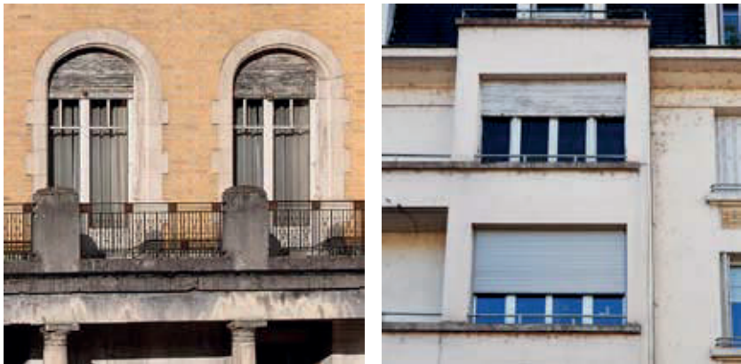
Volets roulants anciens : aucun caisson extérieur n'est visible. Jusqu'à une période récente ils sont en bois. En cas de remplacement on veillera à choisir un matériau permettant les mises en couleur d'origine. 116
