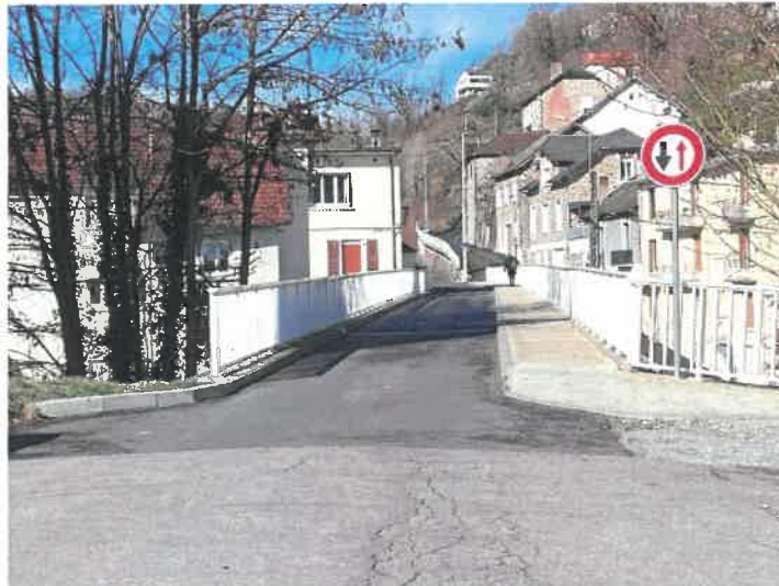
Figure 13 : Pont restauré sur la Corrèze
