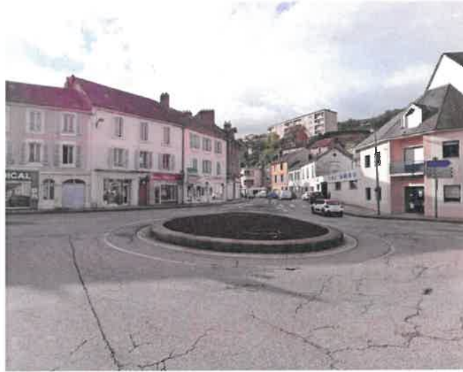
Figure 2 : Chaussée faïencée Giratoire Alsace Lorraine / Rue des Martyrs
