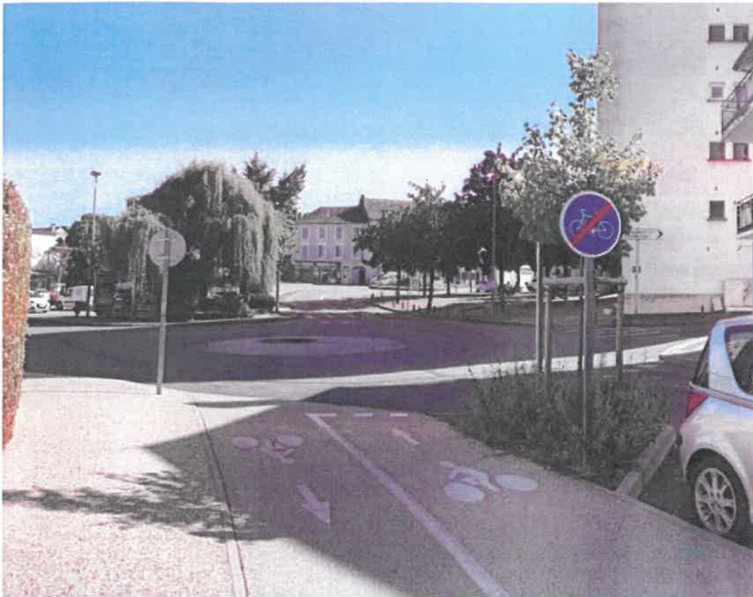
PHOTOS DU SITE EXISTANT septembre 2023
