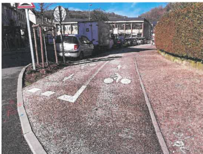
Figure 11 : Revêtements actuels sur la rue du 9 Juin 1944
