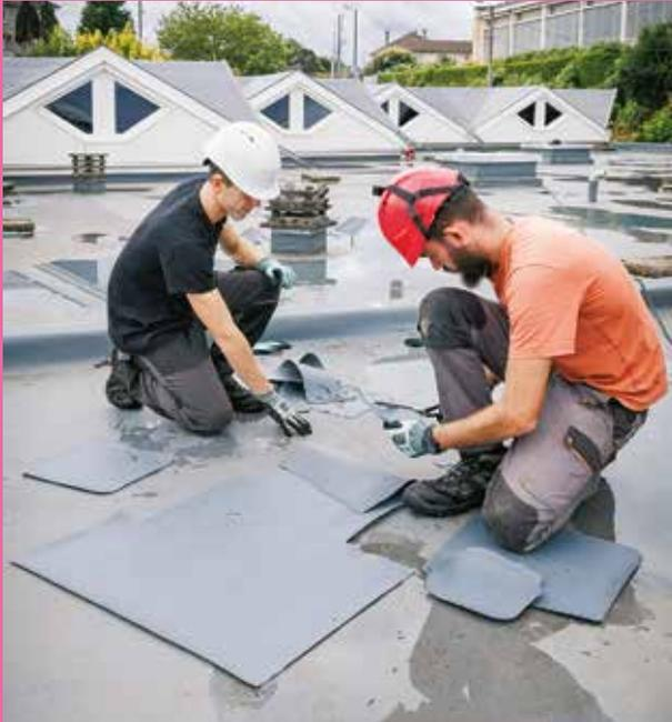
L'entreprise SMAC a effectué une reprise partielle de la membrane d'étanchéité de la toiture terrasse et a remplacé les skydômes (lanterneaux) de l'école Clément-Chausson. Une intervention qui complète les travaux déjà réalisés sur ce site cette année (changement des tympans et des fenêtres) pour limiter les infiltrations d'eau sur le toit plat.
